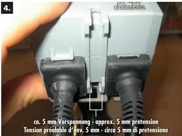
4. Vorspannung des Motors einstellen: Bei geschlossen anliegender, festgehaltener Klappenstellung den Motor ca. 5mm außermittig nach rechts verdrehen. Beide Muttern des Wellenbefestigungsbügels fest anziehen (ca. 6 Nm) (siehe Abb. 2).
