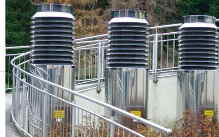
Zuluftröhre für einen Vergnügungspark  $\varnothing$  500 mm, Höhe 2,5 m mit eingebauten Ventilatoren
