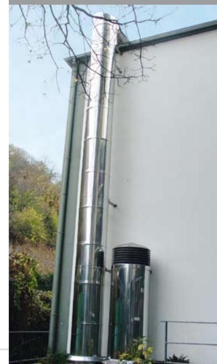
Zuluftturm einer Turnhalle,  $\varnothing$  900 mm, Höhe 6 m, Oberfläche glasperlgestrahlt
