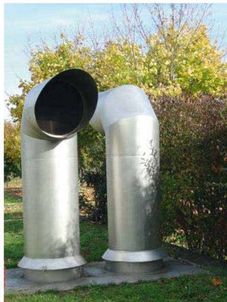
Auslassbögen einer Tiefgarage,  $\varnothing$  700 mm, Höhe 2,2 m, Oberfläche glasperlgestrahlt
