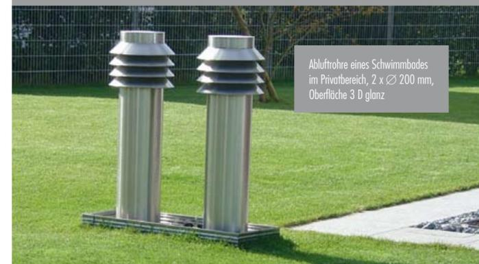
Ablufttröhre eines Schwimmbades im Privatbereich, 2 x  $\varnothing$  200 mm, Oberfläche 3 D glanz
