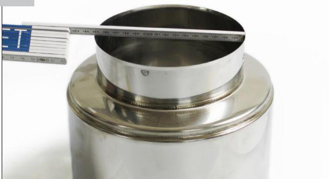
3. Im nächsten Schritt wird der vorhandene Einsteckdurchmesser am Schornstein ermittelt (mit Meterstab, Maßband o. ä.)
