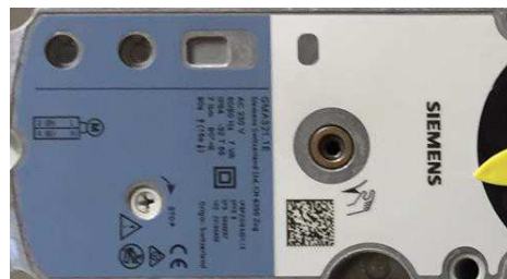
Abbildung 2: Typenbezeichnung (Beispiel) auf Stellantrieb (nur bei Typenreihe mit integrierter Bypassklappe)
