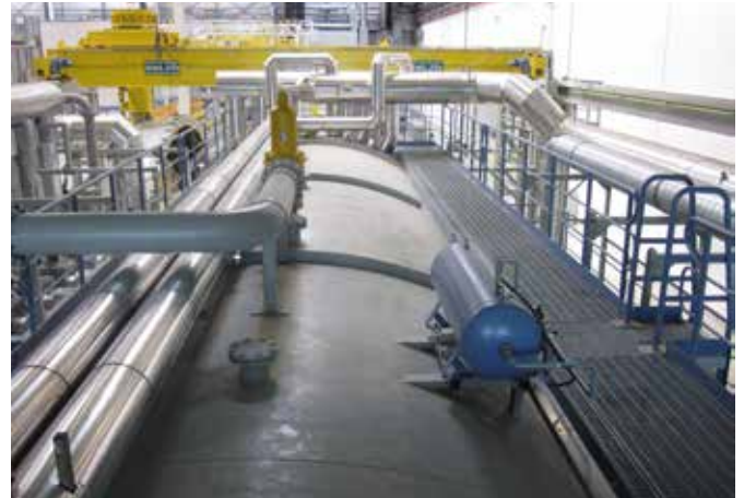
Die Abgasführung an der Ober- und Unterseite des Autoklavs aus dem einwandigen Edstahlssystem EW-Alkon von Raab.
