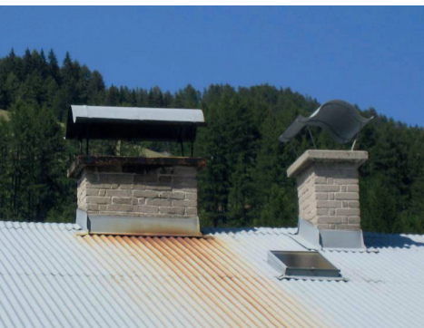
Typische Bilder von Kaminschäden, verursacht durch eine schlechte Verbrennung, Zugverhältnisse oder einer ungeeigneten Abdeckung.
