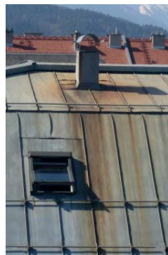
Typische Bilder von Kaminschäden, verursacht durch eine schlechte Verbrennung, Zugverhältnisse oder einer ungeeigneten Abdeckung.
