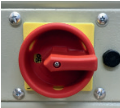
Abb. 2: Not-Halt = Hauptschalter
