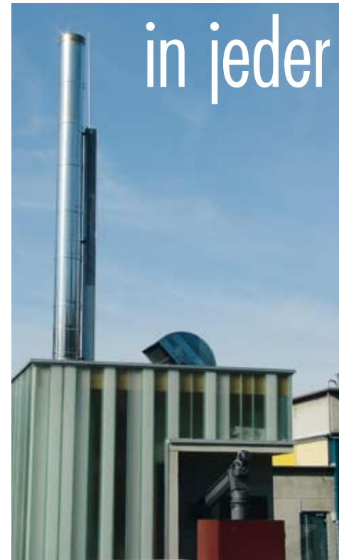
Heizhaus eines Schwimmbades, Lörach Tragmast 240 x 240 mm, Elemente \varnothing 500 mm
