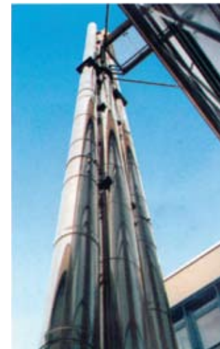
Klinikum Dessau: DIN 4133-Anlage nach Raab- Standard angebunden und der Gebäudefassade angeglichen
