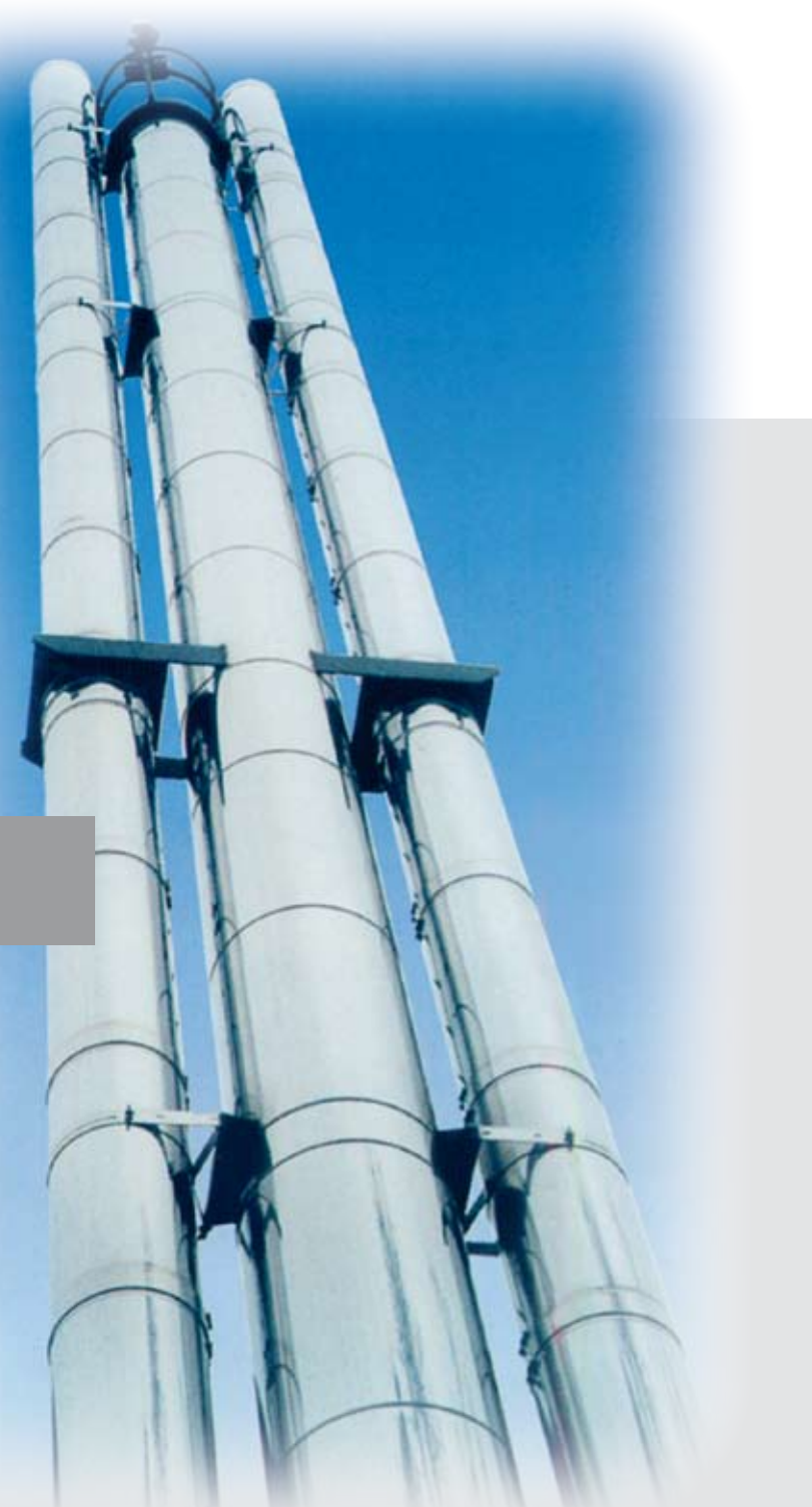
Heizhaus eines Schwimmbades, Lörach Tragmast 240 x 240 mm, Elemente \varnothing 500 mm
