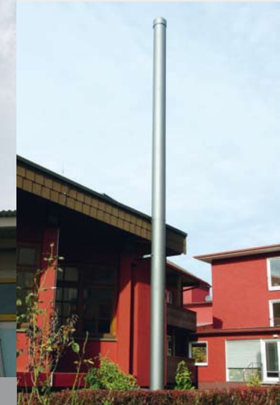
Klinik Bad Krozingen: DIN 4133, \varnothing 350 mm, außen tragend, Oberfläche anthrazit lackiert
