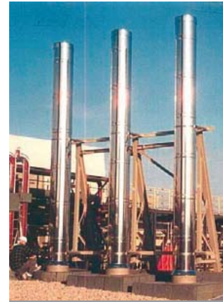
Industrieanlage Heraeus, Bitterfeld Verlängerung von 3 Schornsteinen \varnothing 400 mm
