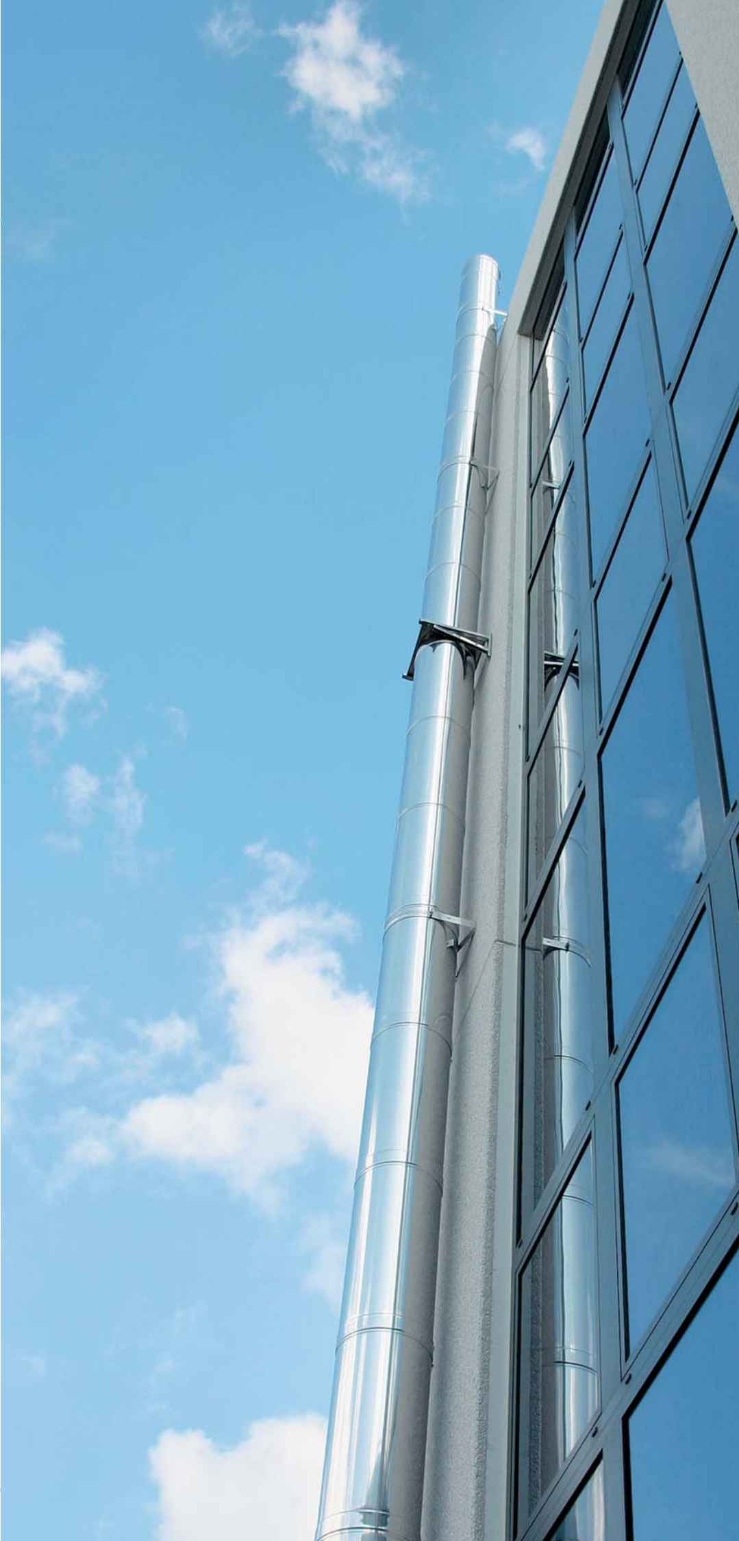
Darstellung DW + DW/FU an der Außenfassade einer Industriehalle
